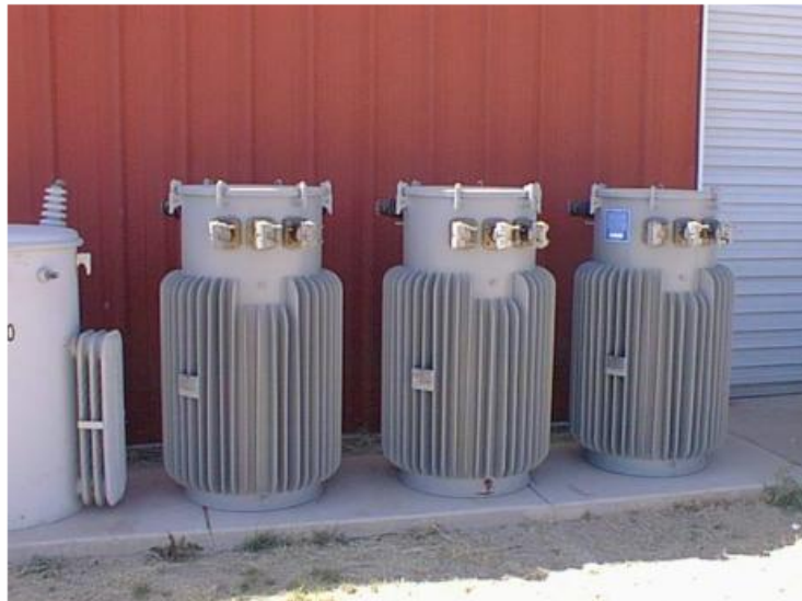
TRANSFORMATEUR DE DISTRIBUTION 50 KVA
